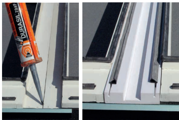
6 - aplicação de cola e veda nas uniões dos módulos e aplicação da caleira.
