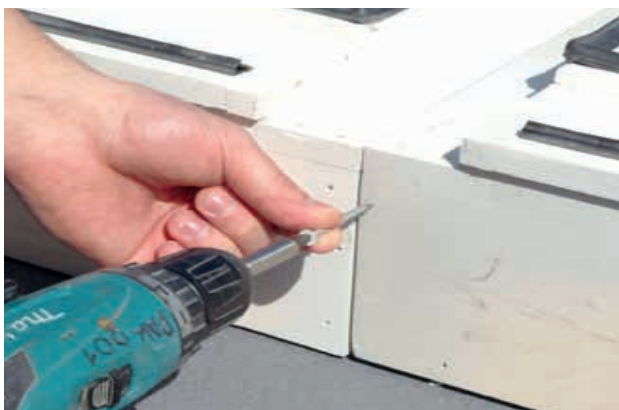
2 - Fixação mecânica dos módulos
