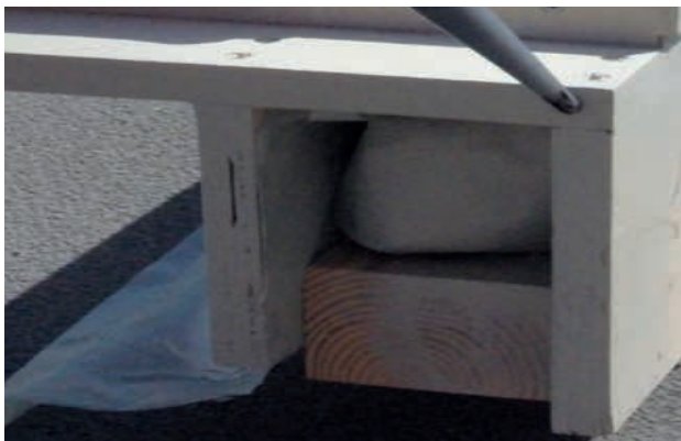
1 - Aplicação de cola e veda nas uniões dos módulos
