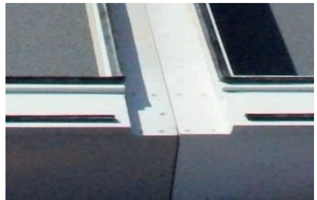
2 - Colocação dos módulos sobre o negativo
