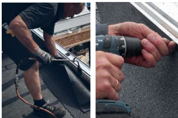
5 - aplicação de tela e perfil de fixação mecânico. (não incluídos)
