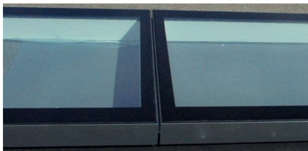
7 - colocação dos vidros sobre os módulos, garantindo um espaçamento de 3mm entre eles.
